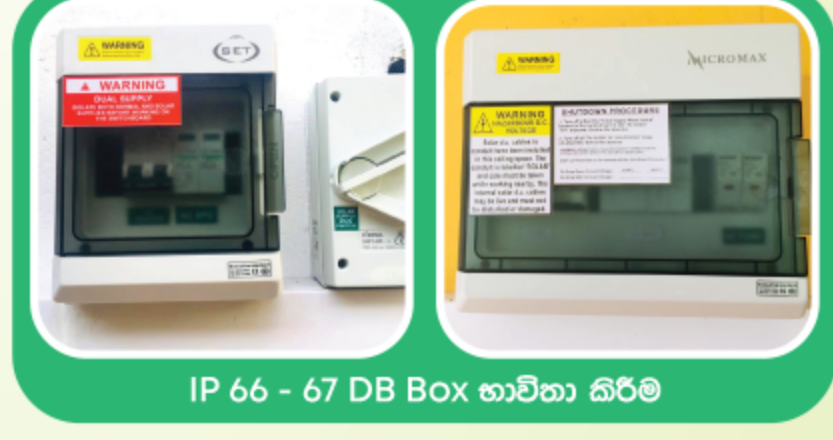
DC ස්ට්‍රින්ග් වලට වෙන වෙනම බ්‍රේකර්ස් භාවිතය
